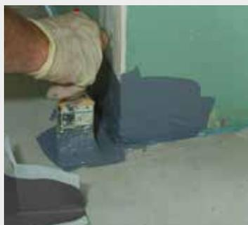
L'angolo viene prima preparato con uno strato di KÖSTER BD 50, che dovrebbe coprire ca. 10 cm del muro e 10 cm del pavimento.
