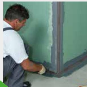
KÖSTER BD Flex Tape K 120 costituisce un collegamento resistente alle fessure fra l'impermeabilizzazione dalla parete e quella pavimento. Viene installata nelle giunzioni parete/pavimento e negli angoli interni ed esterni.
