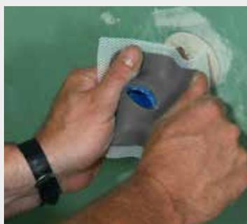
La toppa elastica KÖSTER BD Wall Sleeve viene infilata sopra l'estremità del tubo.
