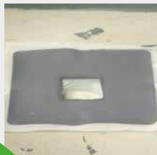
Viene ricavato un foro della forma e delle dimensioni dello scarico sulla toppa elastica KÖSTER BD Floor Sleeve. Si prega di notare che KÖSTER BD Floor Sleeve dovrebbe sbordare di ca. 3 mm verso l'interno nello scarico a pavimento.
