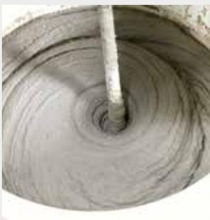
Il componente in polvere viene miscelato con 7 - 7,5 litri di acqua potabile in un contenitore pulito. Mescolare continuamente con un agitatore meccanico a rotazione lenta aggiungendo la polvere.
