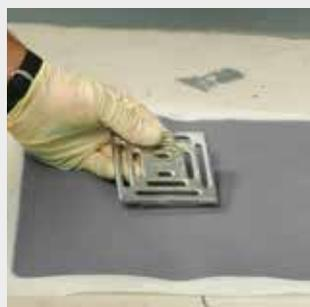
KÖSTER BD Floor Sleeve viene posizionato sopra lo scarico a pavimento.
