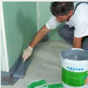
La zona di passaggio parete-pavimento viene preparata con uno strato di KÖSTER BD 50, che dovrà coprire ca. 10 cm del muro e 10 cm del pavimento.
