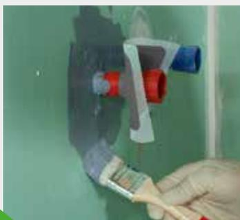
L'area attorno all'attraversamento del tubo viene preparata con uno strato di KÖSTER BD 50. KÖSTER BD Wall Sleeve viene annegata nello strato ancora fresco di KÖSTER BD 50.
