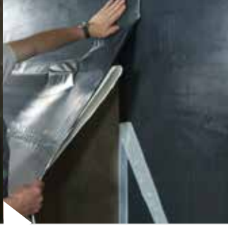
Applicazione della membrana
