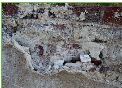
Danno tipico da efflorescenze saline.
