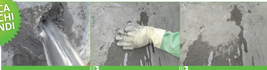
Una perdita attiva è bloccata istantaneamente con l'applicazione di KÖSTER KD 2 Blitz.
