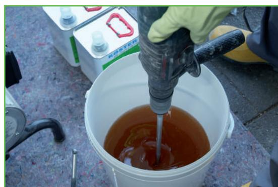
*Utilizzare una frusta appropriata come la KÖSTER Resin Stirrer e un trapano miscelatore a bassa velocità per miscelare entrambi i componenti fino ad ottenere un composto omogeneo.*
