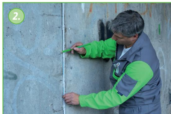
2. Segnare la posizione dei fori. I fori da iniezione sono posizionati lungo l'estensione della fessura, a lati alternati, ad una distanza dai 10 cm ai 15 cm.
