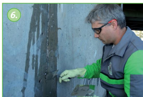
*Sigillare la fessura lungo la sua estensione con KÖSTER KB Fix 5. In questo modo si impedisce al materiale iniettato di fuoriuscire prematuramente dalla fessura. Il tempo di presa è di circa 5 minuti e dipende dalle condizioni di temperatura e umidità ambientali.*
