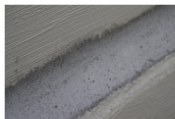
2. Sguscia realizzata con KÖSTER Repair Mortar
